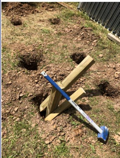
Enfoncer les pieux à la masse de 20 à 30 cm minimum en maintenant la bonne verticalité. Astuce : bloquer le pieux avec des chutes de bois ou des pierres (voir photo) pour les enfoncer plus facilement et sans taper sur les doigts de la personne venue donner un coup de main.
