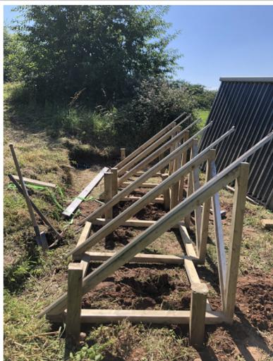
Positionner la structure à son emplacement définitif pour identifier la position des pieux. 4 par structure dans notre cas.
