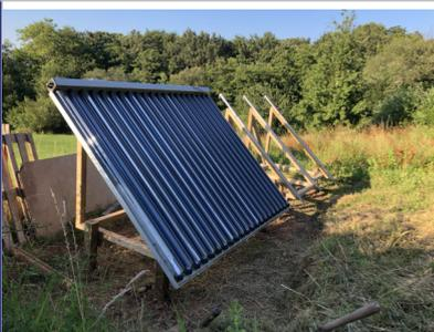
Fixer les panneaux à la structure. Dans notre cas des barres métalliques fournies avec les panneaux nous ont permis de faire le lien entre le panneau et la structure en bois.
